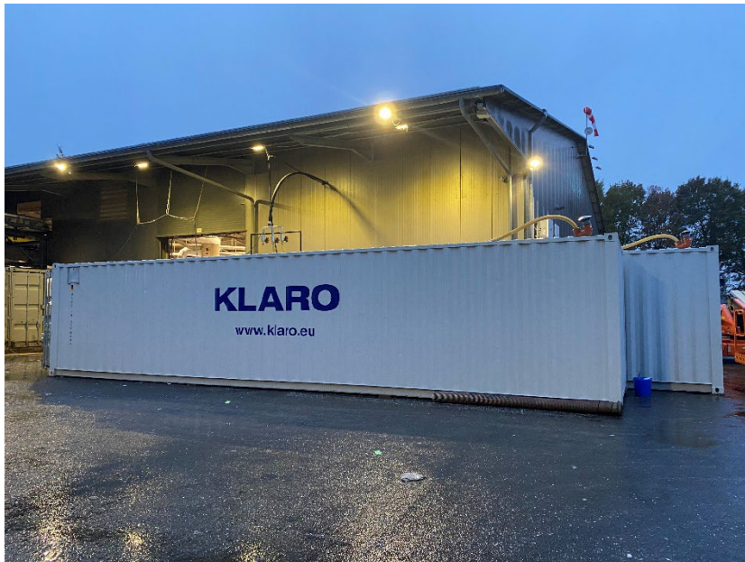
Bild 1: 600 EW Containeranlage in drei 40-Fuß Containern
