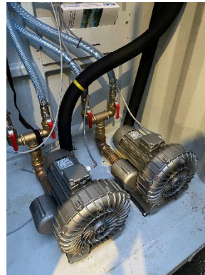
Bild 5: Verdichter
