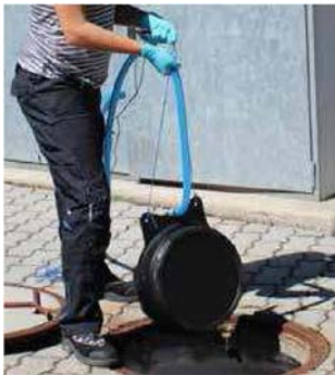
Bild 1: Einsatz beschwerter KLARO Belüfter
