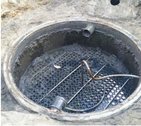
Bild 3: Zugewachsener Festbettreaktor (30 EW)
