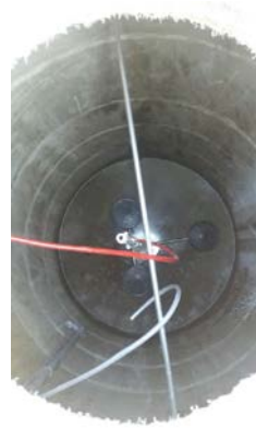
Bild 3: Zugewachsener Festbettreaktor (30 EW)
