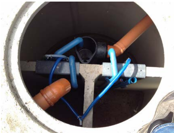
Bild 5: Nachrüstung mit KLARO airlift.blue (mit Schläuche)
